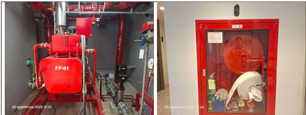
รูปที่ 1.5.3-7 ระบบป้องกันอัคคีภัยของโครงการ Rangsit Residence II (รังสิต เรสซิเดนซ์ 2)
