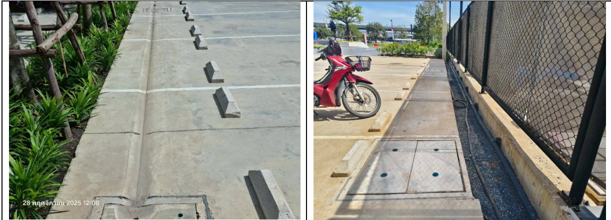
รูปที่ 1.5.3-3 ระบบระบายน้ำและป้องกันน้ำท่วมของโครงการ Rangsit Residence II (รังสิต เรสซิเดนซ์ 2)
