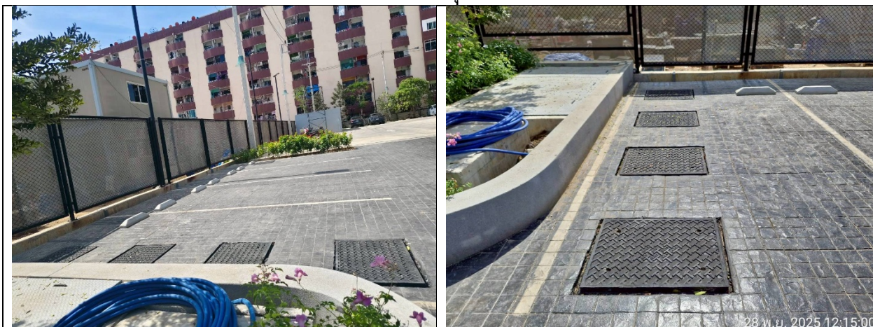
บ่อดักขยะและตะแกรงดักขยะภายใน
